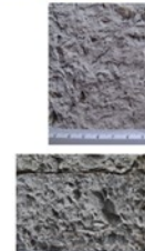
Finiture superficiali dei conci in alberese della chiesa di Moriano con tracce di strumento a punta.
